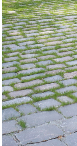
Pflaster mit Rasenfuge
